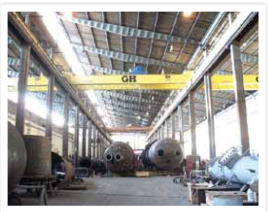
Nova ponte rolante na Caldeiraria
