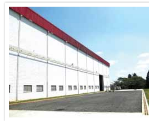
Área onde será instalado o pórtico
